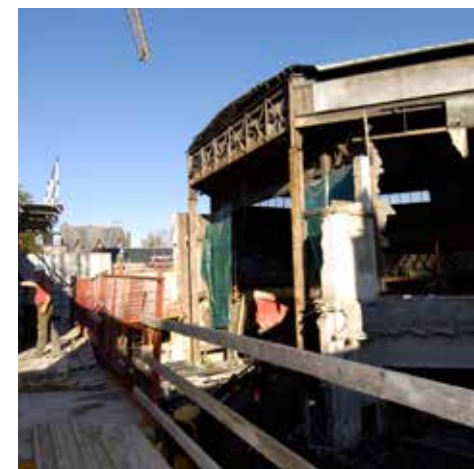
Ci-dessus Cirque-théâtre pendant les travaux, 2007 © MRN - J.F. LANGE
