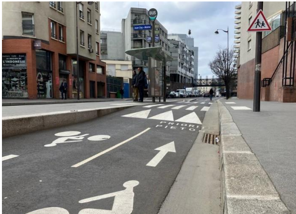
Exemple d'aménagement en arrière de quai (Paris), source : CEREMA
