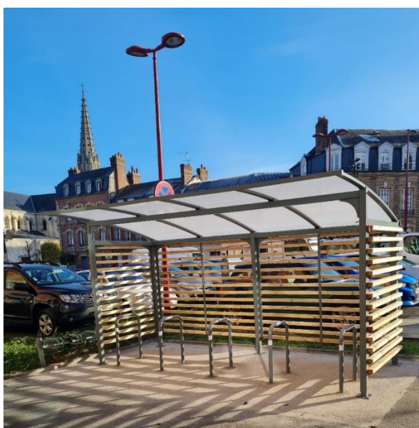
Abris-vélos, Fabrique des savoirs, Elbeuf
