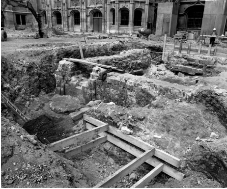
Chantier de fouilles sous la cour du palais de justice – 1976 © Service de l'inventaire – conseil régional de Normandie
