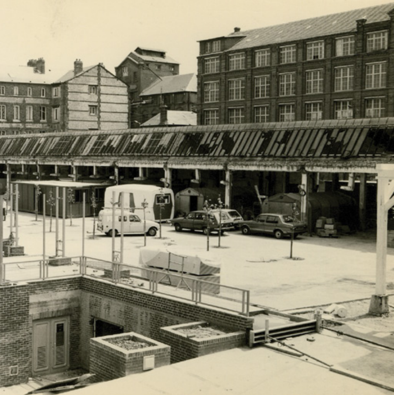
Les travaux de reconversion de l'usine Blin d'Elbeuf vers 1980 C.A.P. Don Jacques Thoraval (3Fi6163)
