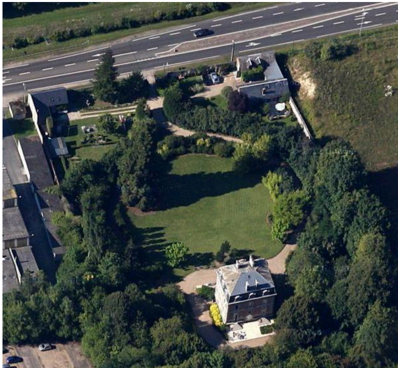
Figure 7 : 3 habitations du secteur Avenue de Caen actuellement non desservies par le réseau
