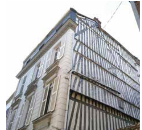
Vue sur la face nord du n°29, rue des Requis - Essentes © MRN – Maud BACCARA
