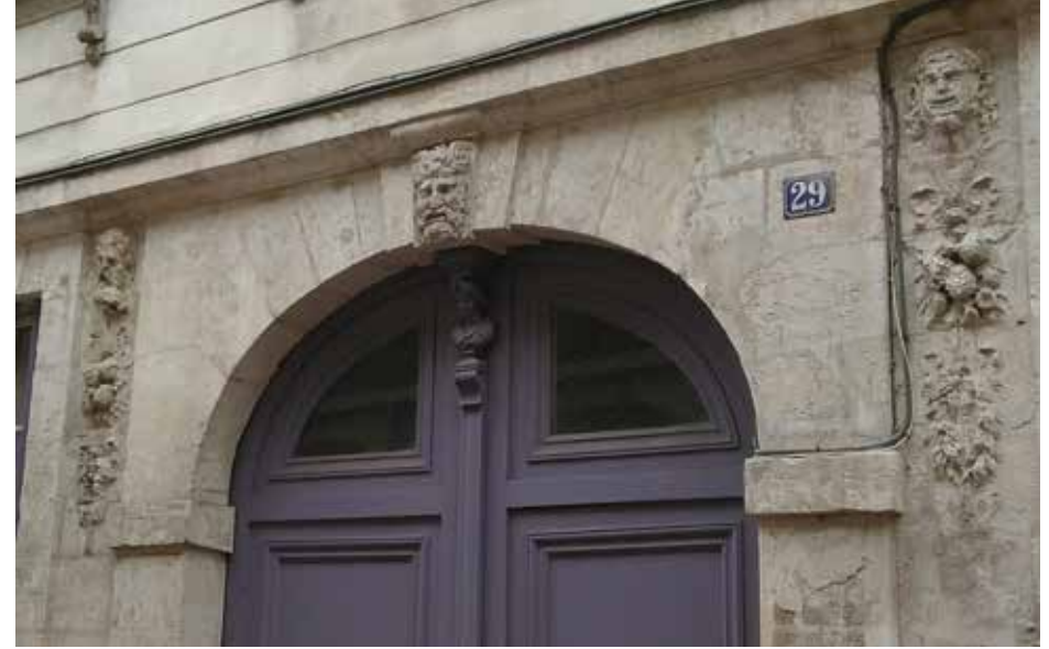
Portail du rez-de-chaussée du n°29, rue des Requis - 2019 © MRN – Maud BACCARA
