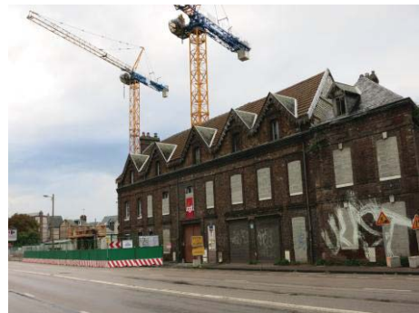
Aux limites entre Rouen et Petit Quevilly : La nécessité de requalifier et de densifier.
