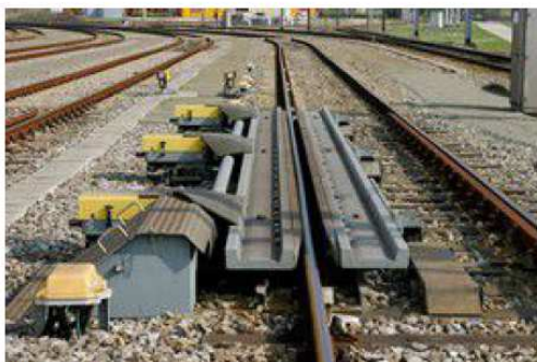
illustration 27 : rail freineur (gare d'Antwerpen)
