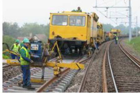
illustration 20 : longs Rails soudés sur traverses béton
