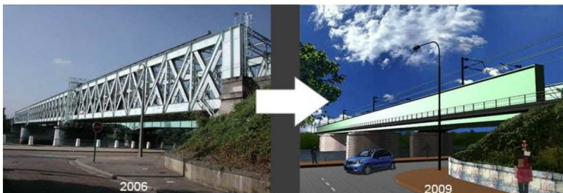
illustration 21 : changement de pont métallique à Oissel
