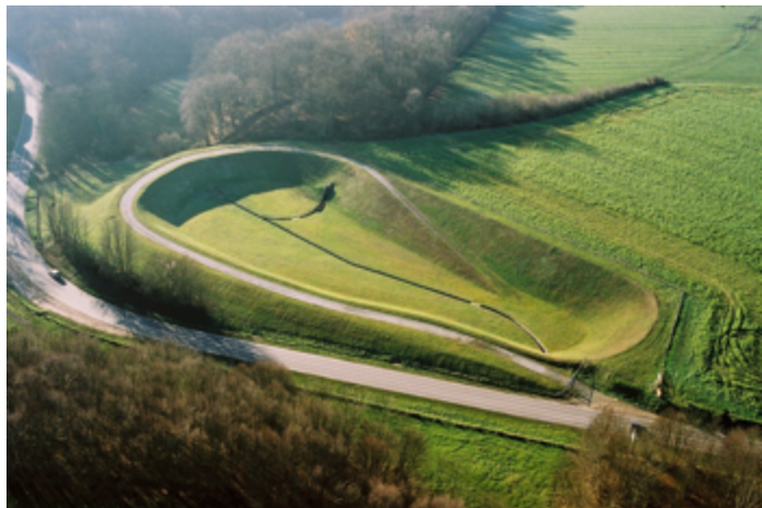
Bassin de rétention à ciel ouvert, Route de Belbeuf, Franqueville-Saint-Pierre
